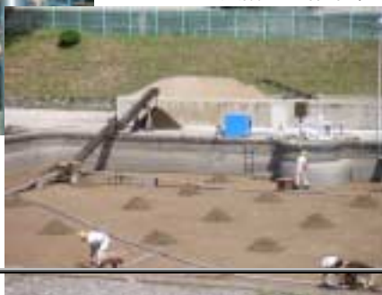
ろ過膜削りの作業中
