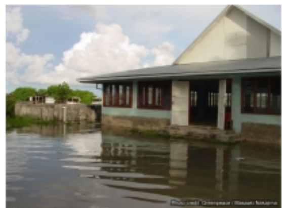
=浸水後= 環礁のため内陸から沸き上がった水によって浸水
